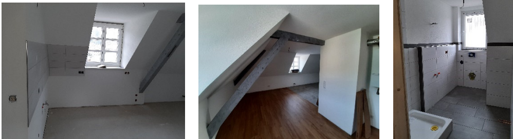
Schaffhauser Straße 48 Neuanlage einer Dachgeschoßwohnung
