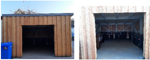
Zeppelinstraße 54/56 Überdachter Müllplatz
